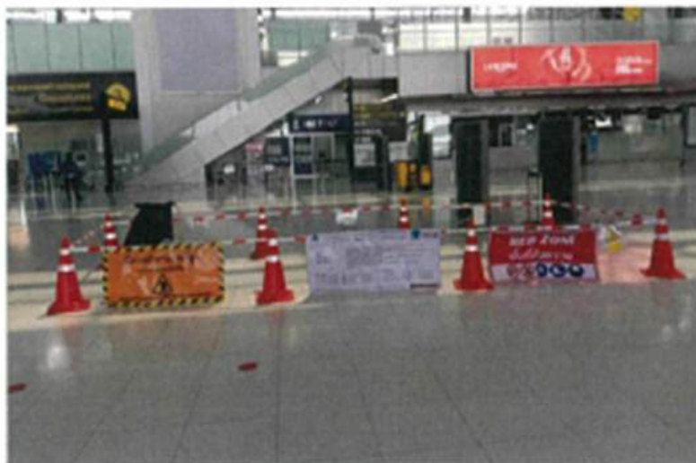
รูปภาพ ปิดกั้นพื้นที่ภายในอาคารผู้โดยสาร บริเวณที่ทำการยกแผง หรือกรณีการซ่อมบำรุงและเปลี่ยนแผงที่ชำรุด
